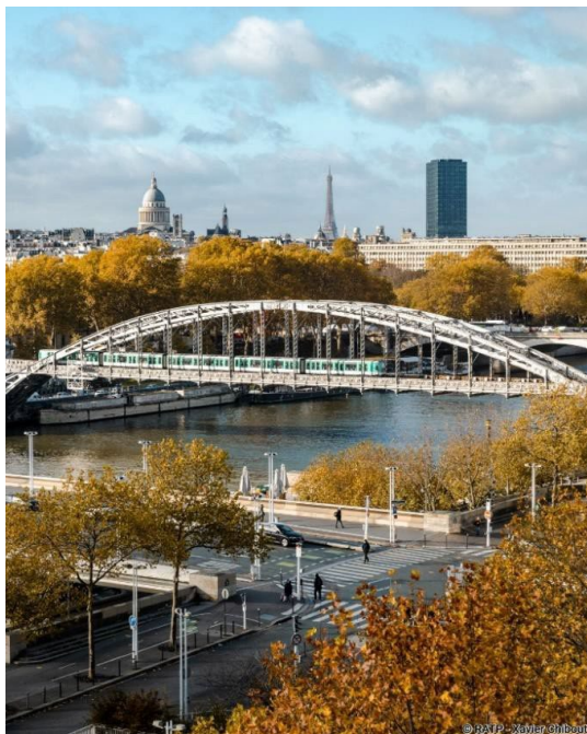
図6：オーステルリッツ高架橋
