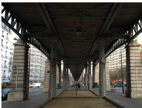
図4：6号線高架橋下部 OSMOSセンサ設置状況
