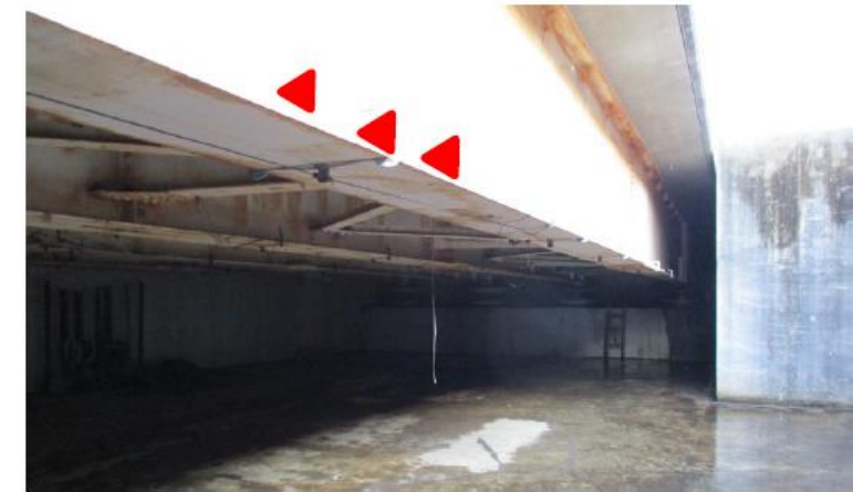
計測対象桁 およびひずみゲージ位置
