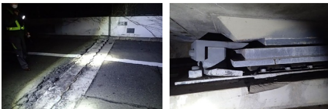
写真-3 2022年3月16日地震直後の現地調査状況
