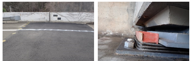
写真-4 応急補修後の状況
