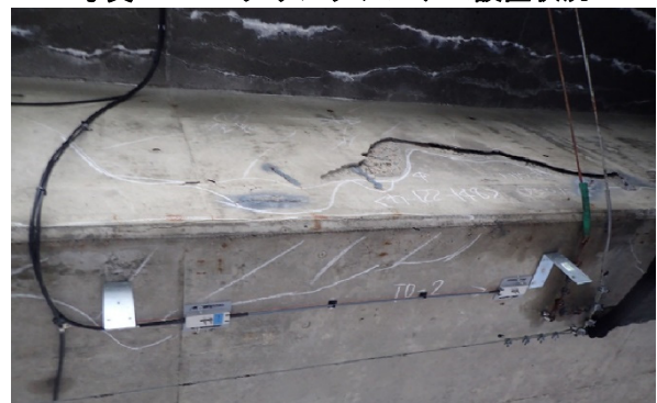
写真-2 光学ストランドセンサ設置 PC 箱桁下面
