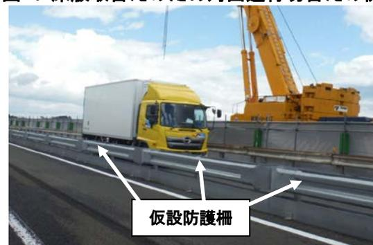
写真-1 仮設防護柵を設置した対面通行状況
