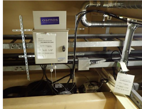
橋梁箱桁内部：ラック掛け
