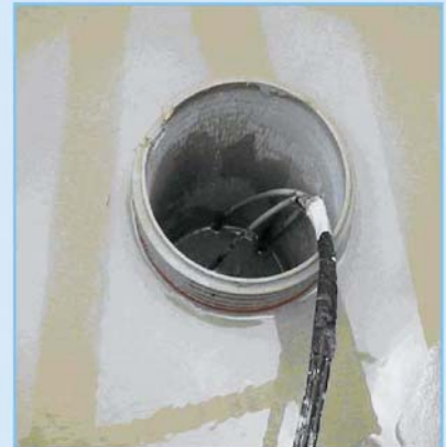
注入口内部の光学ストランド
