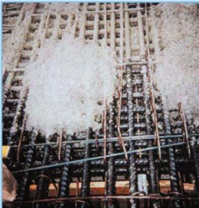
コンクリート打設時の光学ストランド
