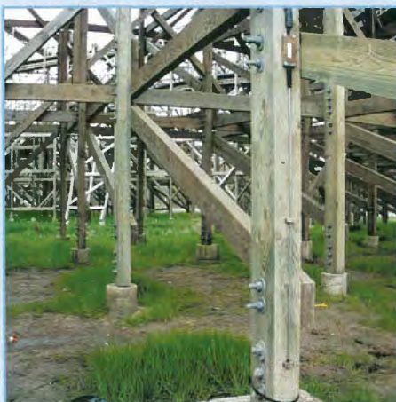
適用例1：木造構造物に設置
