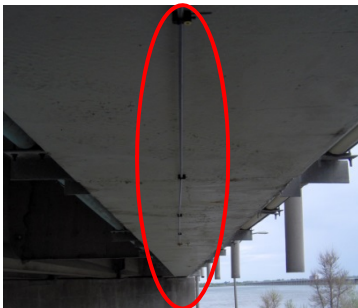
(桁フランジに設置した5mセンサー)
