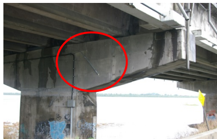
(橋脚せん断面に設置した2mセンサー)
