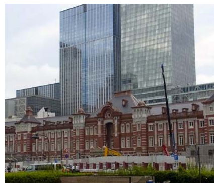
(資料: 東京駅丸の内舎保存・復元工事)
