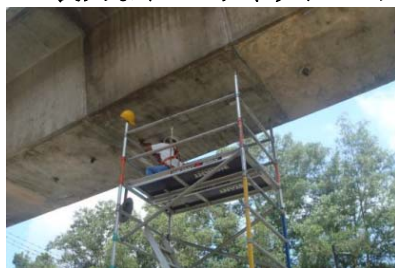
(センサー設置工事)
