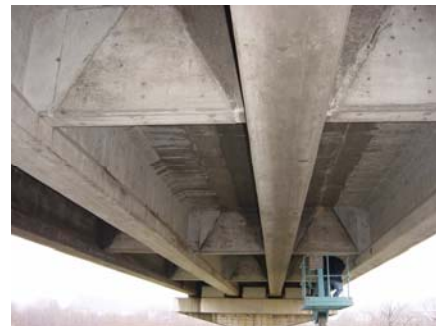
写真-1 S橋下面状況
