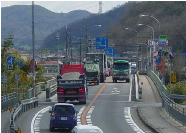
写真-1 道路面の状況
