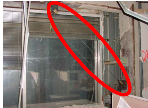
写真-5 梁と柱への設置
