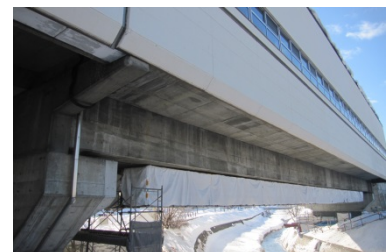
(モニタリング対象のPC箱桁橋)
